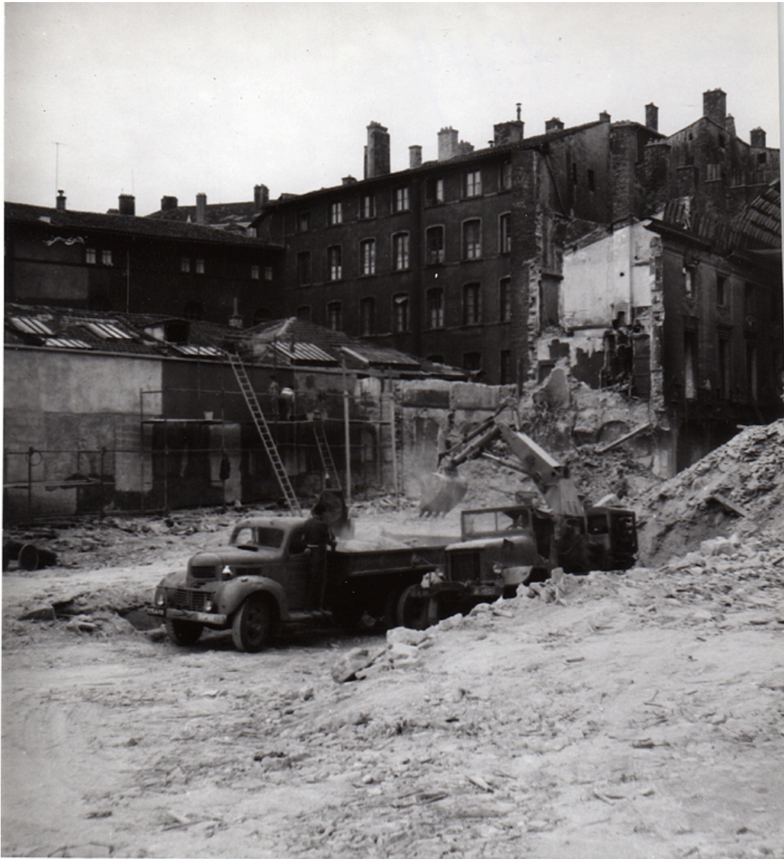
Démolition du passage, élévation intérieure sud avec les bâtiments P et S en arrière-plan
