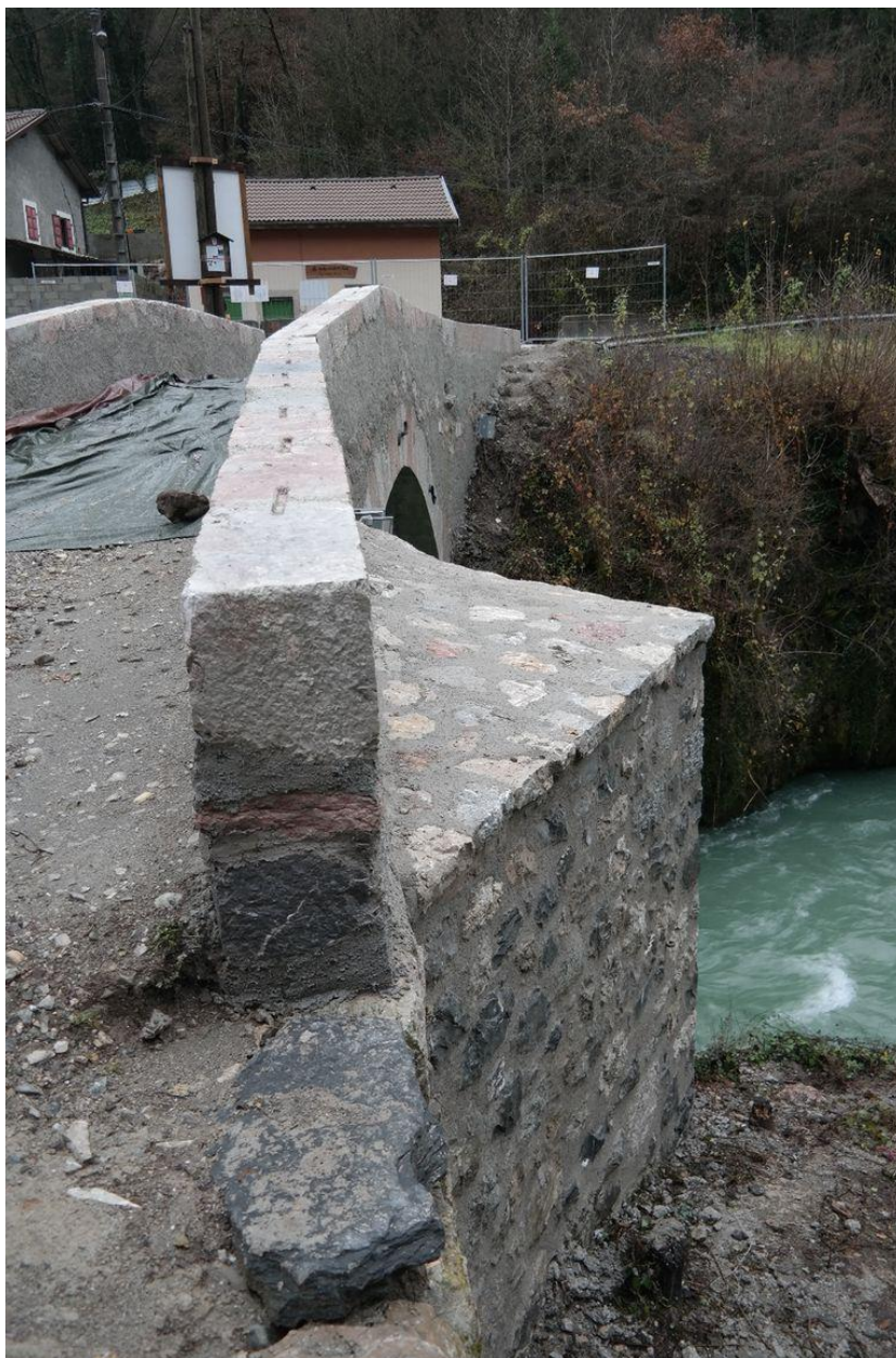
Pont d'Evian, détail parapet et mur de protection
