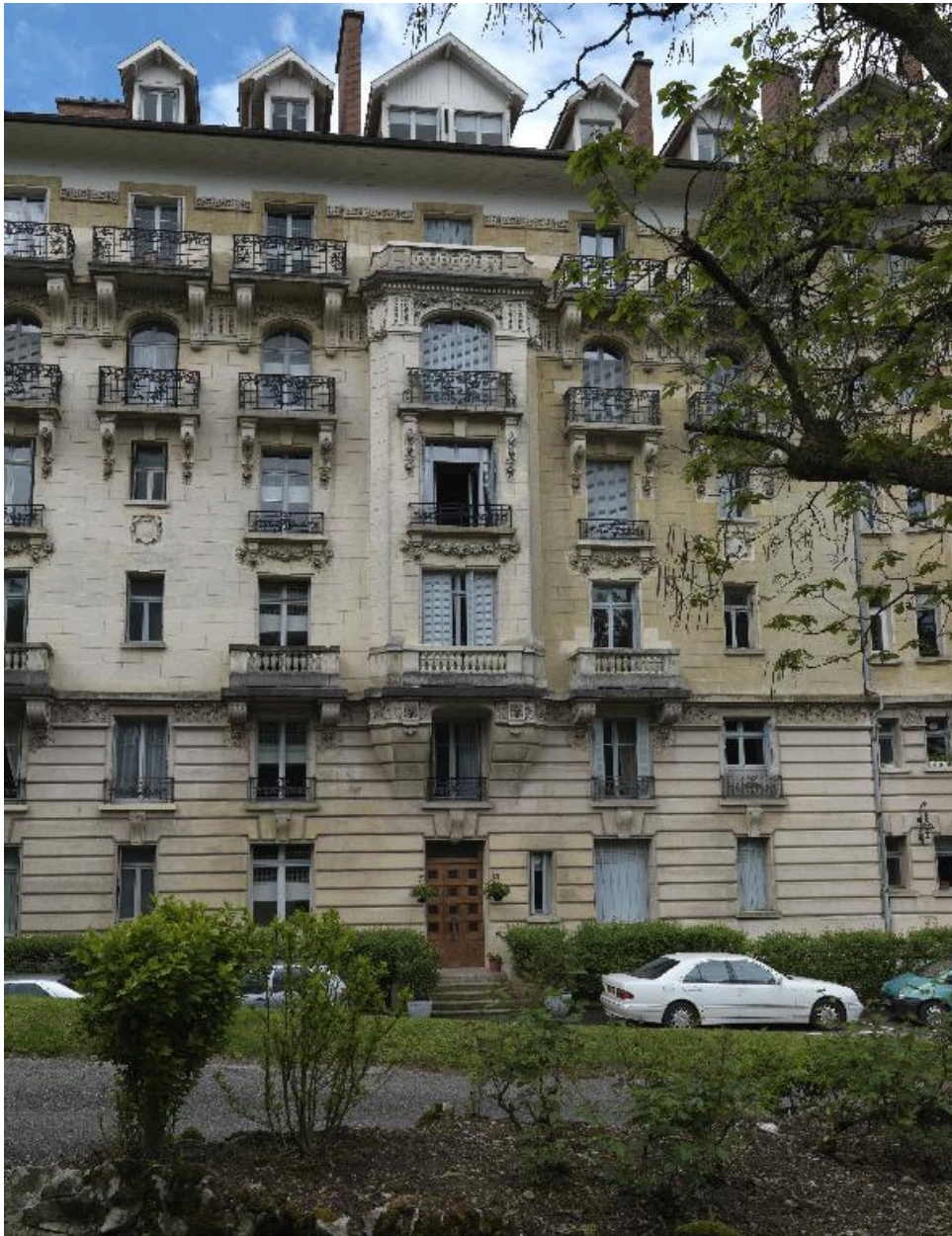
Façade sur cour: détail de l'aile sud
