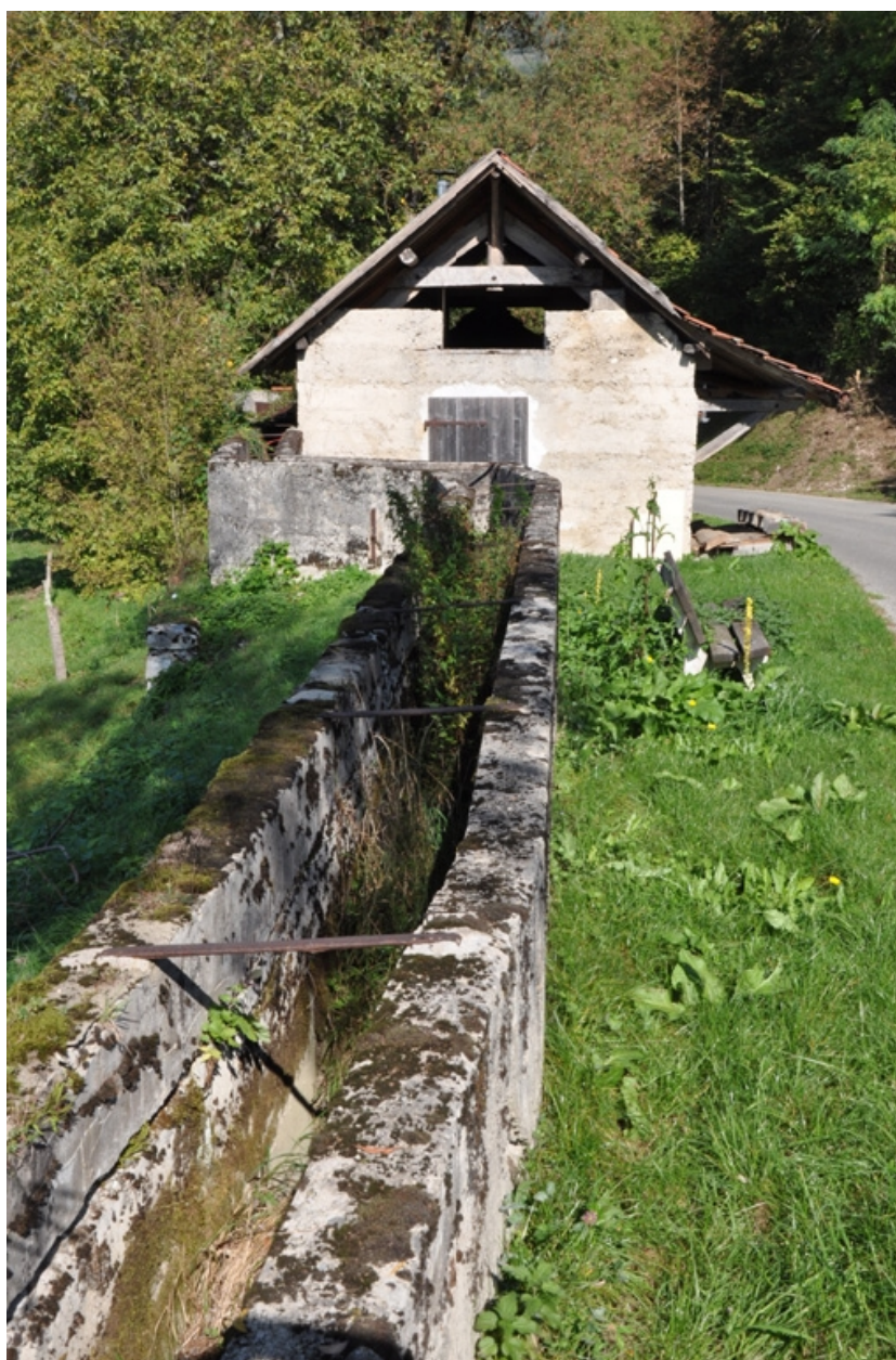
Vue du canal d'amené de la scierie
