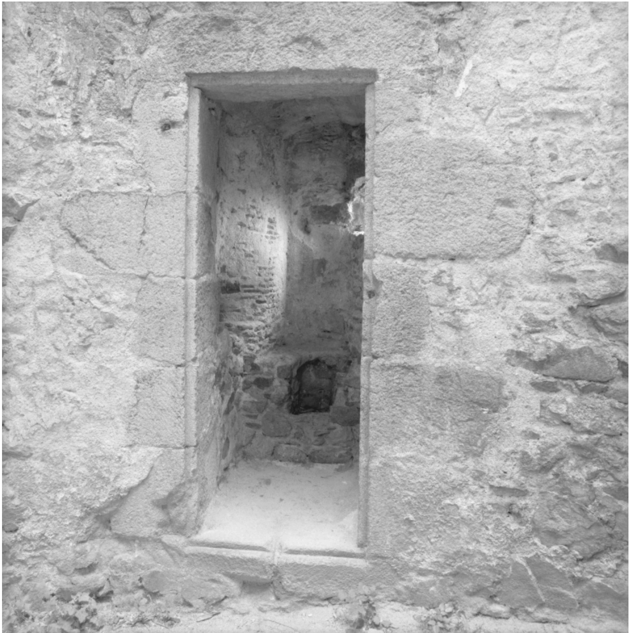
Château-fort primitif, tour dite tour Saint-Antoine : vue des latrines du rez-de-chaussée, du sud-ouest.
