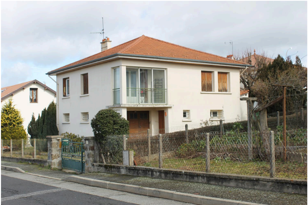
Sainte-Sigolène : les immeubles HLM de la Croix-Saint-Romain et le lotissement Les Érables, une maison type F4 au n° 21, façade principale sud-est et façade sud-ouest.
