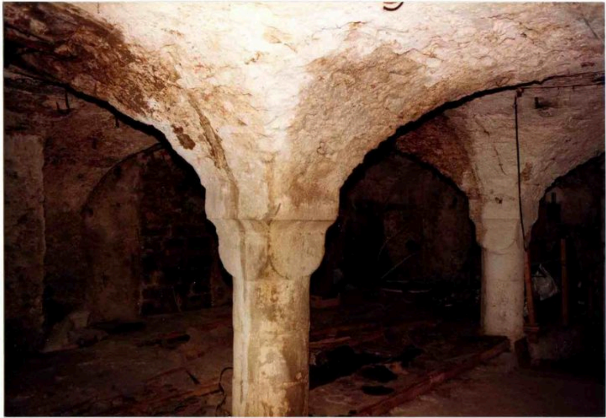
Vue partielle de la cave vers 1980. Photogr. CRMH Rhône-Alpes. 1111 MHAA 99-463
