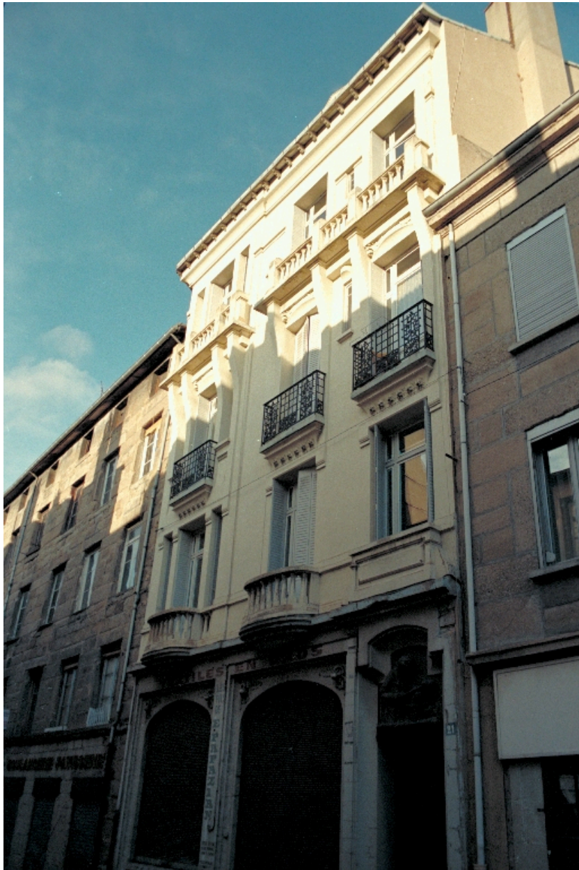
Façade principale. Etat en 1996
