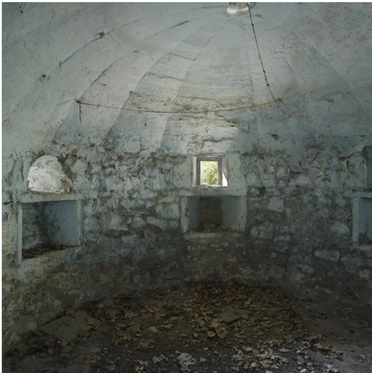
Rez-de-chaussée de la tour nord-ouest
