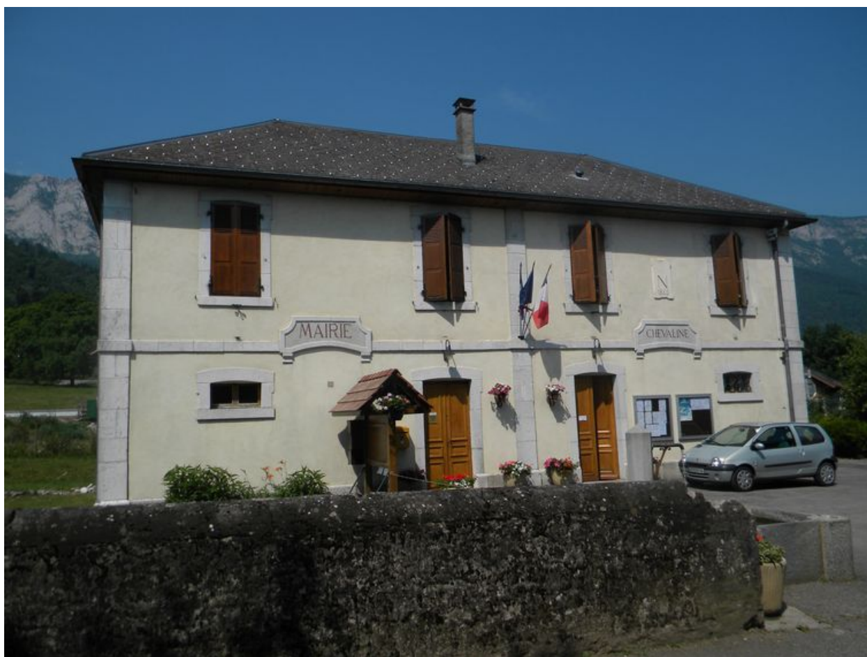
Vue générale depuis la rue principale
