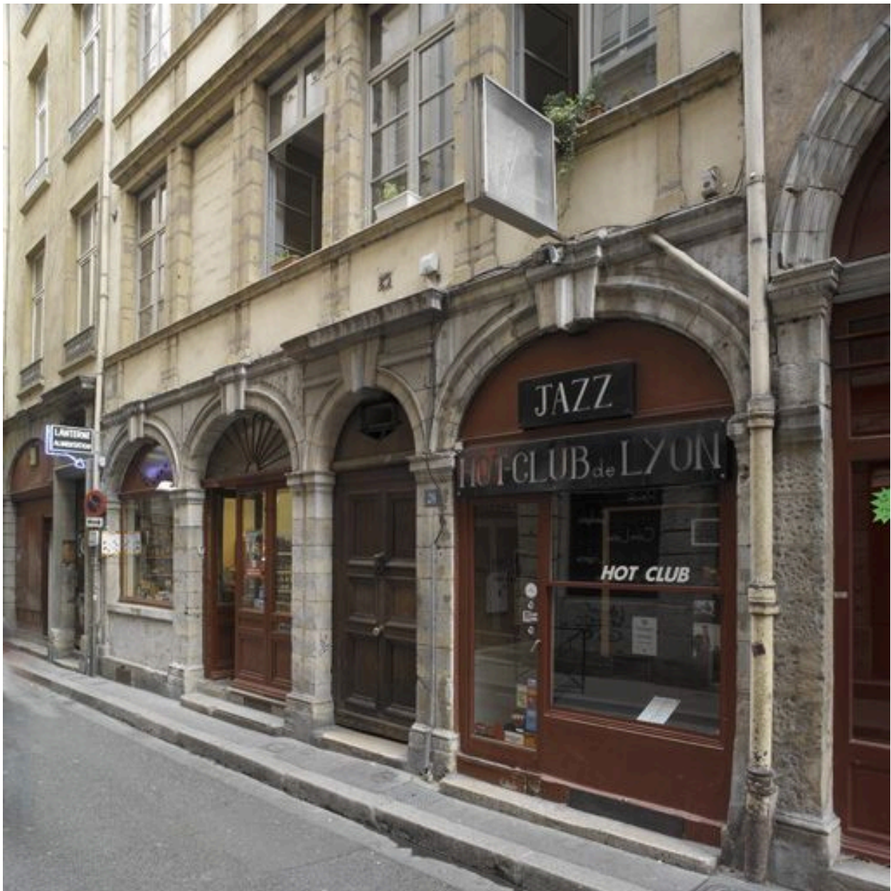
Façade sur rue, rez-de-chaussée vu depuis la droite
