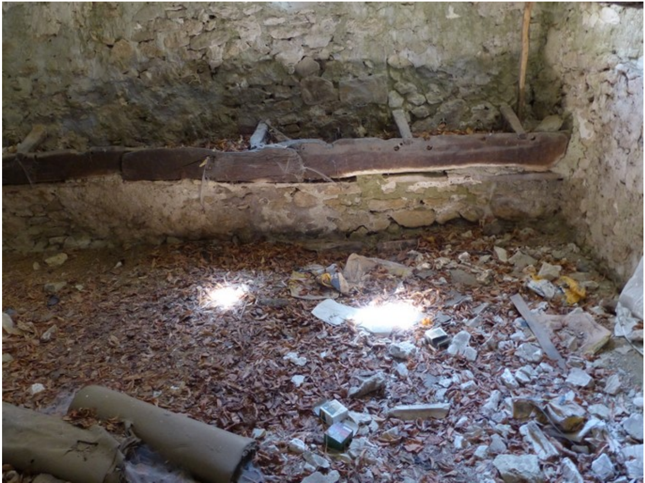
Partie ouest. Premier étage de soubassement, étable. Mur sud, mangeoire.
