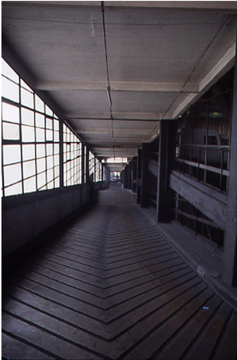
Rampe d'accès façade est
