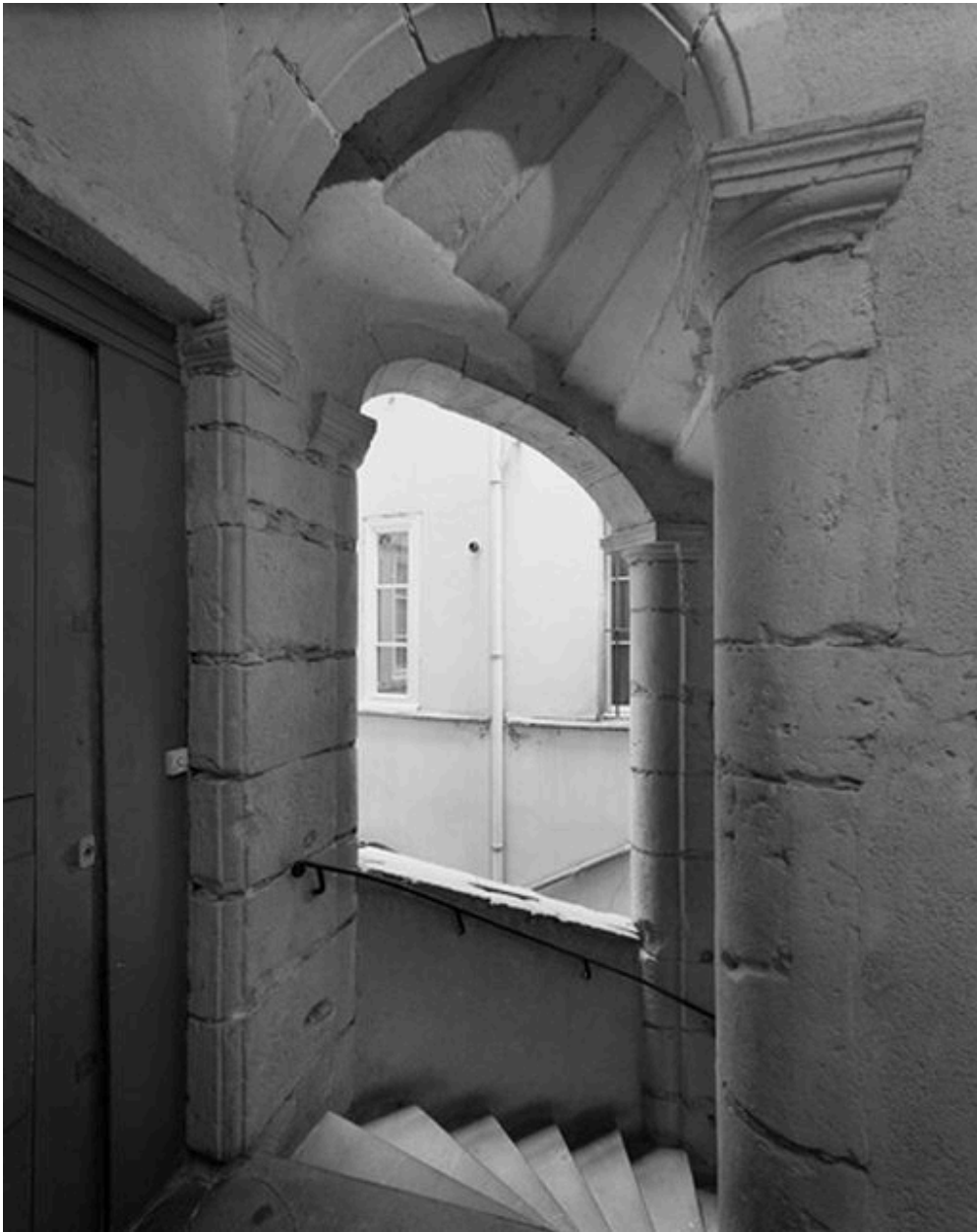
La cage d'escalier
