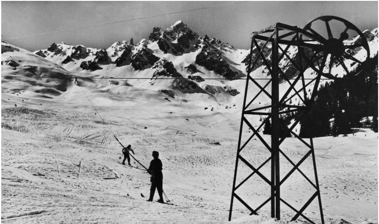
Le télésiège du Biollay. Photogr. Laurent Chappis, 1949 (AD Savoie. 30J classeur 2)
