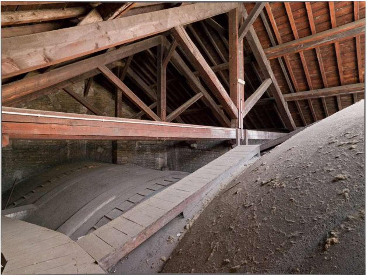
Combles et voûtes.
