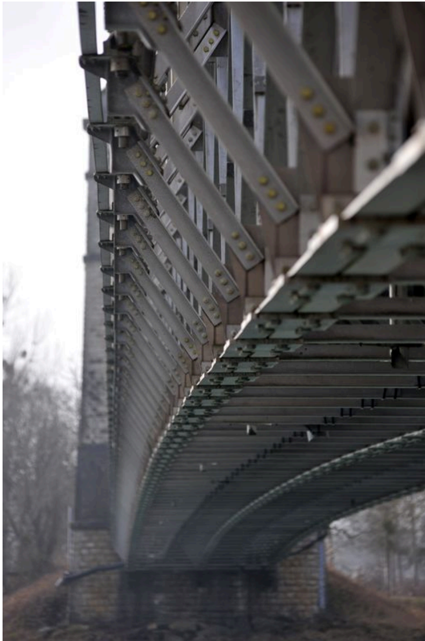
Travée centrale, face amont, vue partielle : structure métallique (depuis la rive droite)
