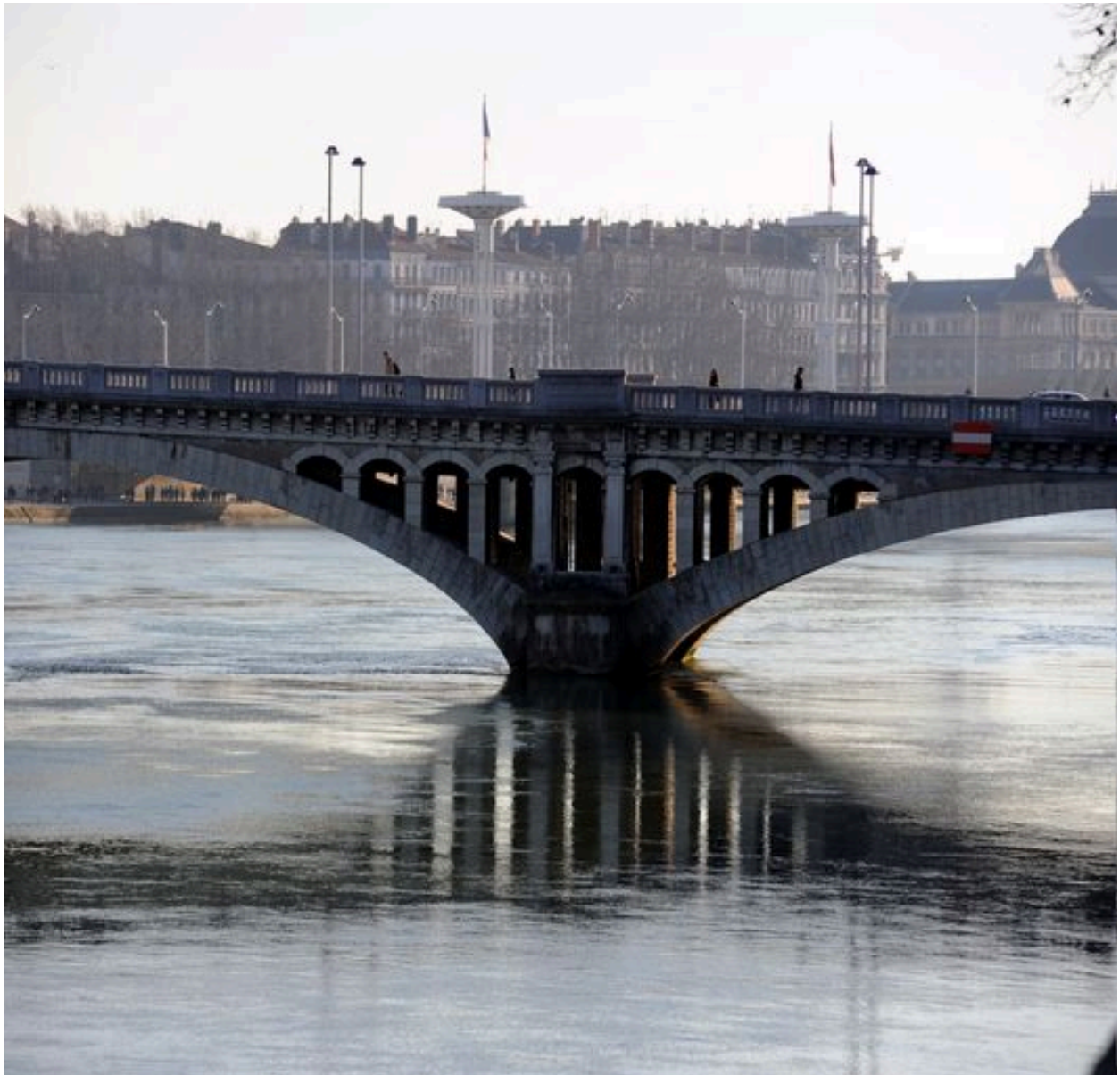
Vue partielle, pile, face amont (depuis la rive droite)
