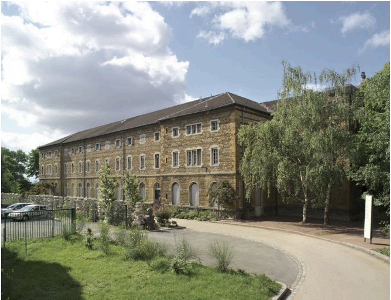
Elévation latérale nord, depuis le nord-ouest
