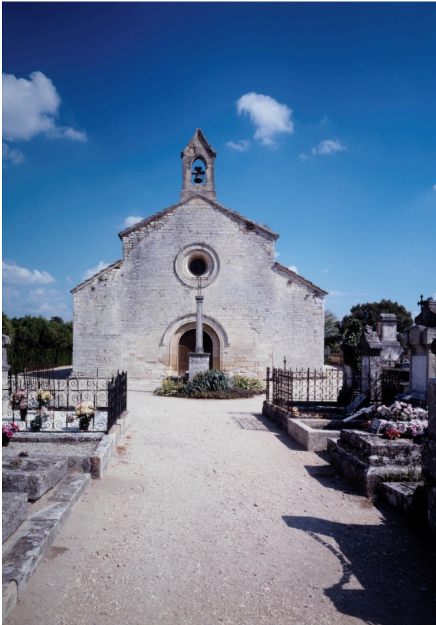
Façade, vue d'ensemble.
