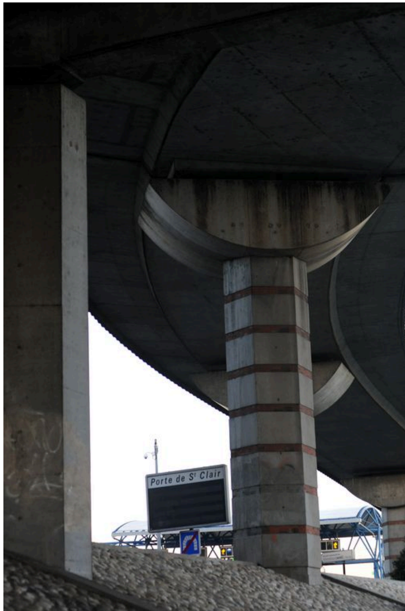
Vue partielle, jonction du tablier et de l'accès routier, de dessous (depuis la rive droite)
