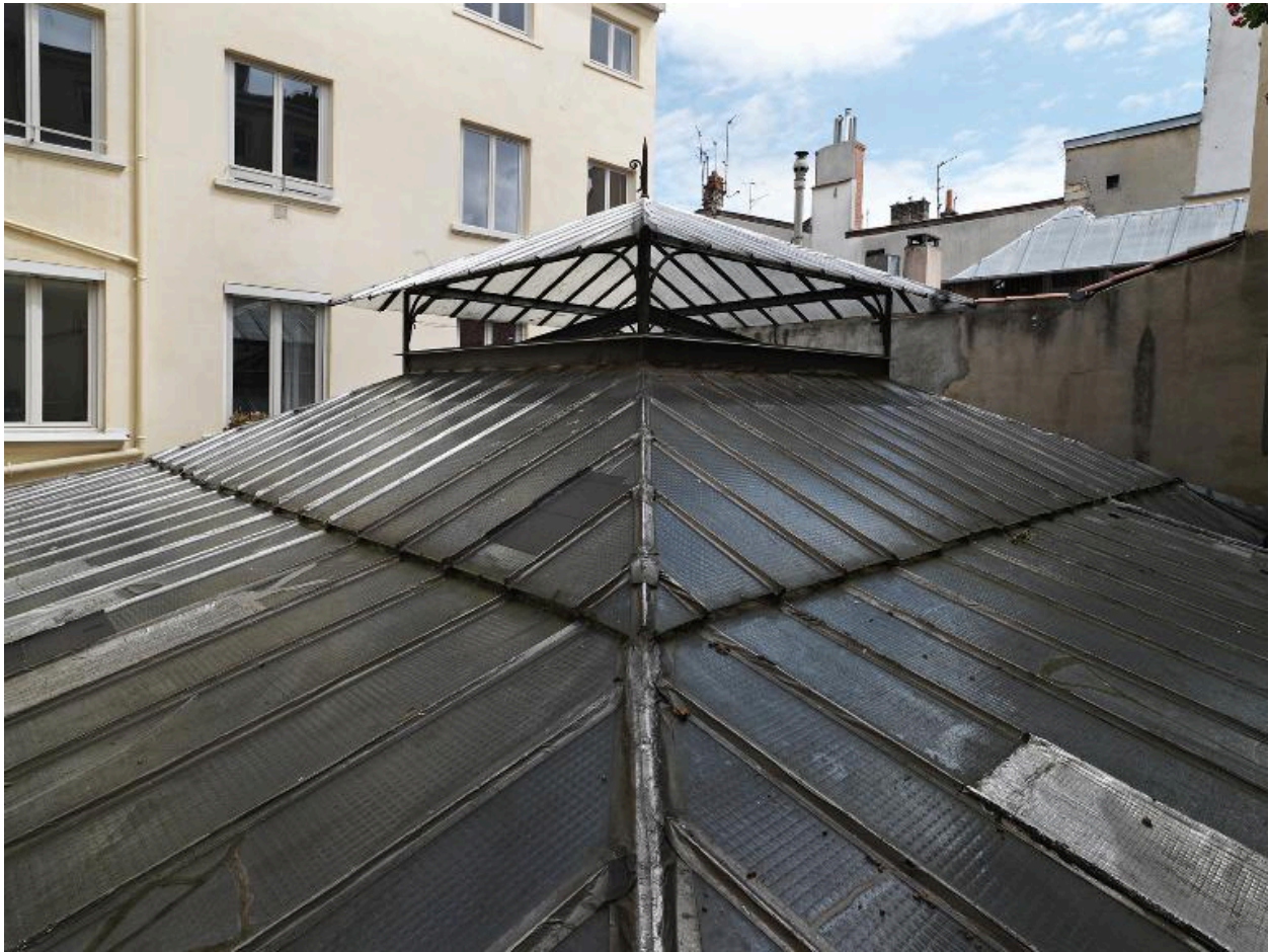
Verrière zénithale de la cour, vue générale extérieure
