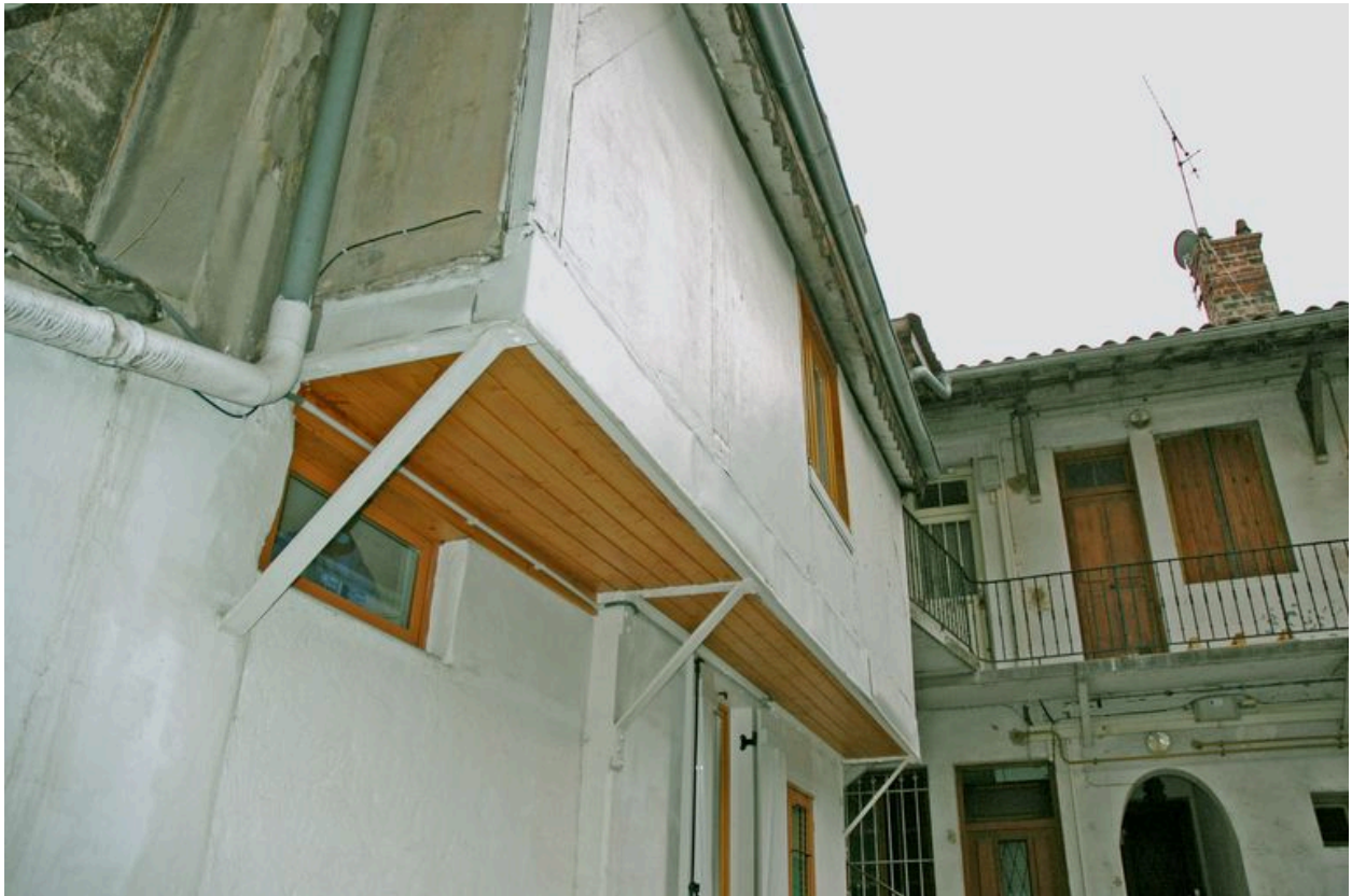
Corps de bâtiment au nord de la cour vue depuis le passage couvert à l'ouest
