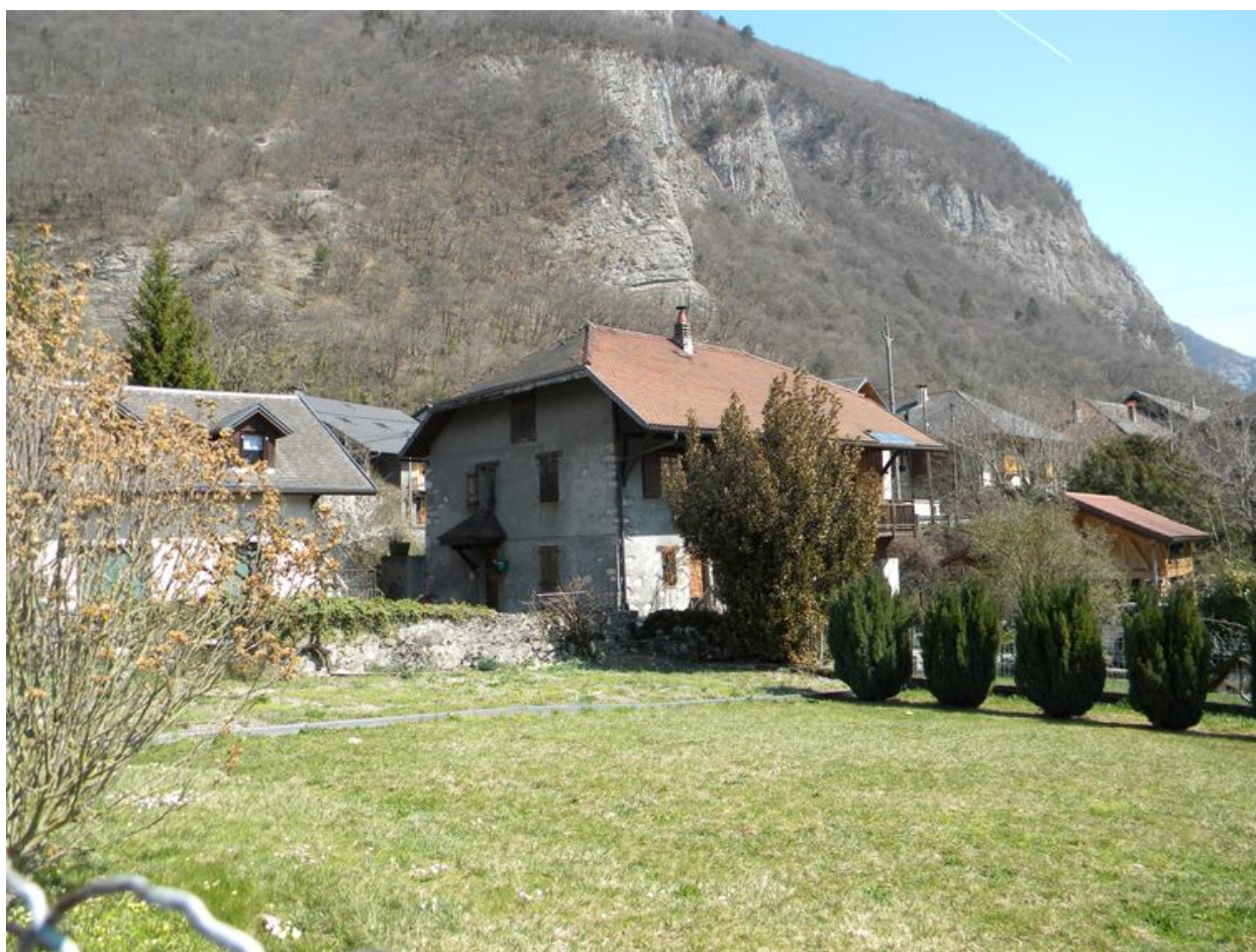
Vue d'ensemble du bâtiment.
