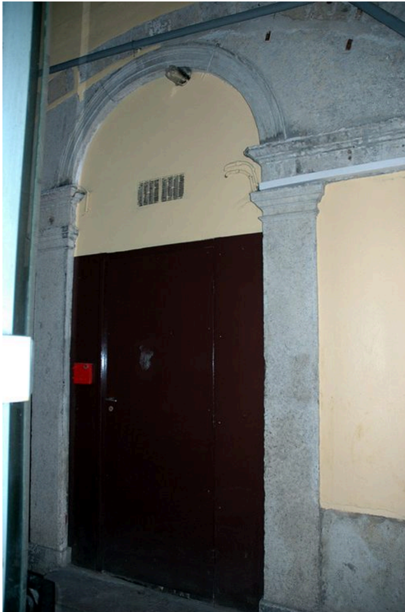
Baie située dans la cour accessible depuis la rue de la Monnaie
