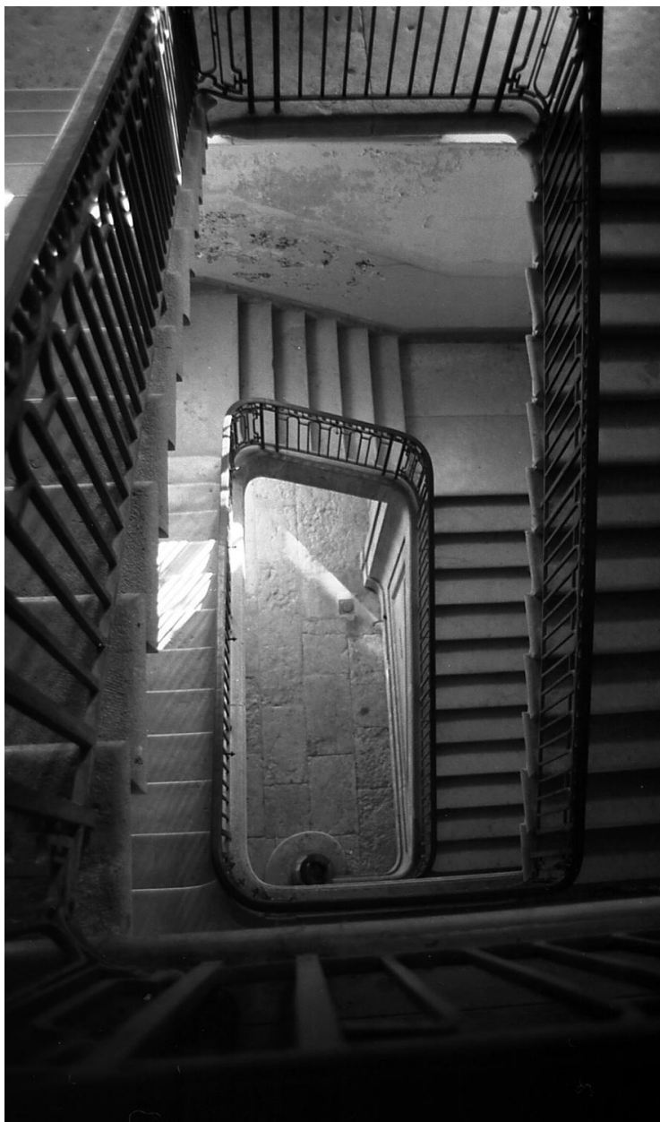
L'escalier C, v.1976 (AP Plantin)
