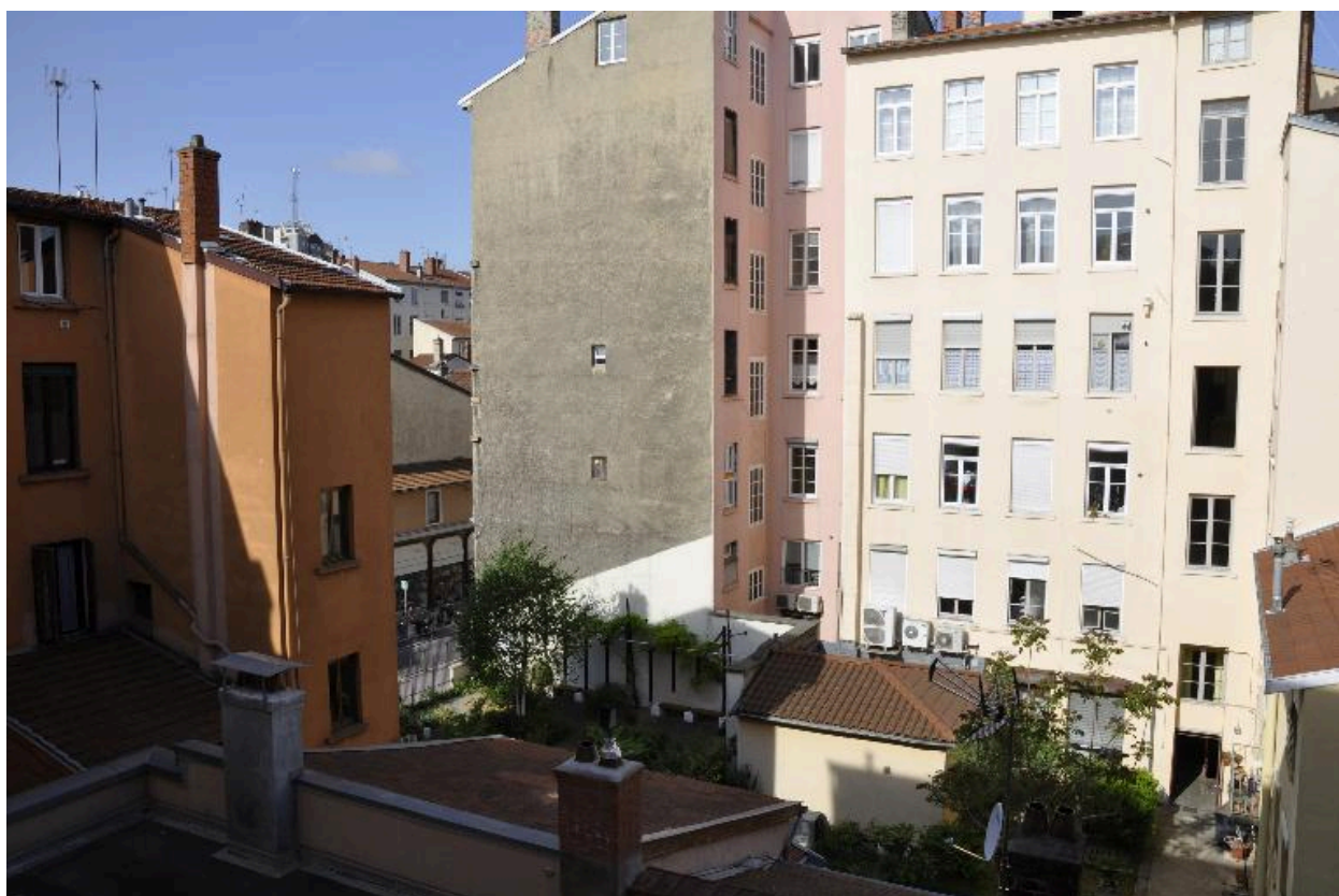
Vue d'ensemble depuis le n° 17 rue du Mail
