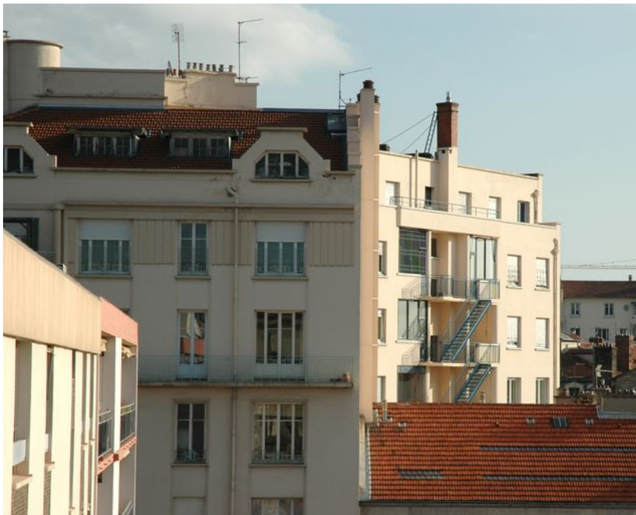
Détail des étages supérieurs depuis l'ouest
