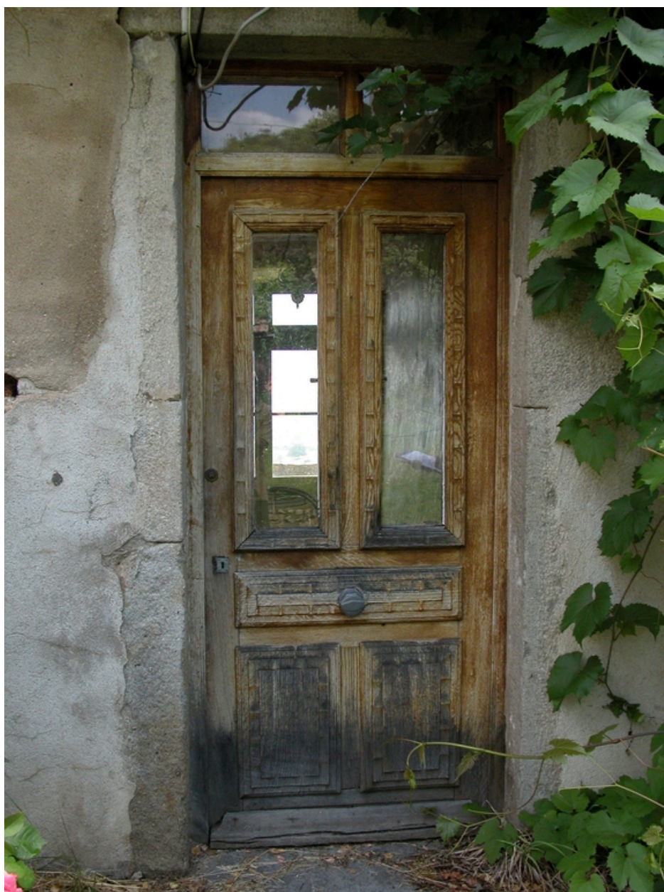
Détail de la porte d'entrée (côté ouest).
