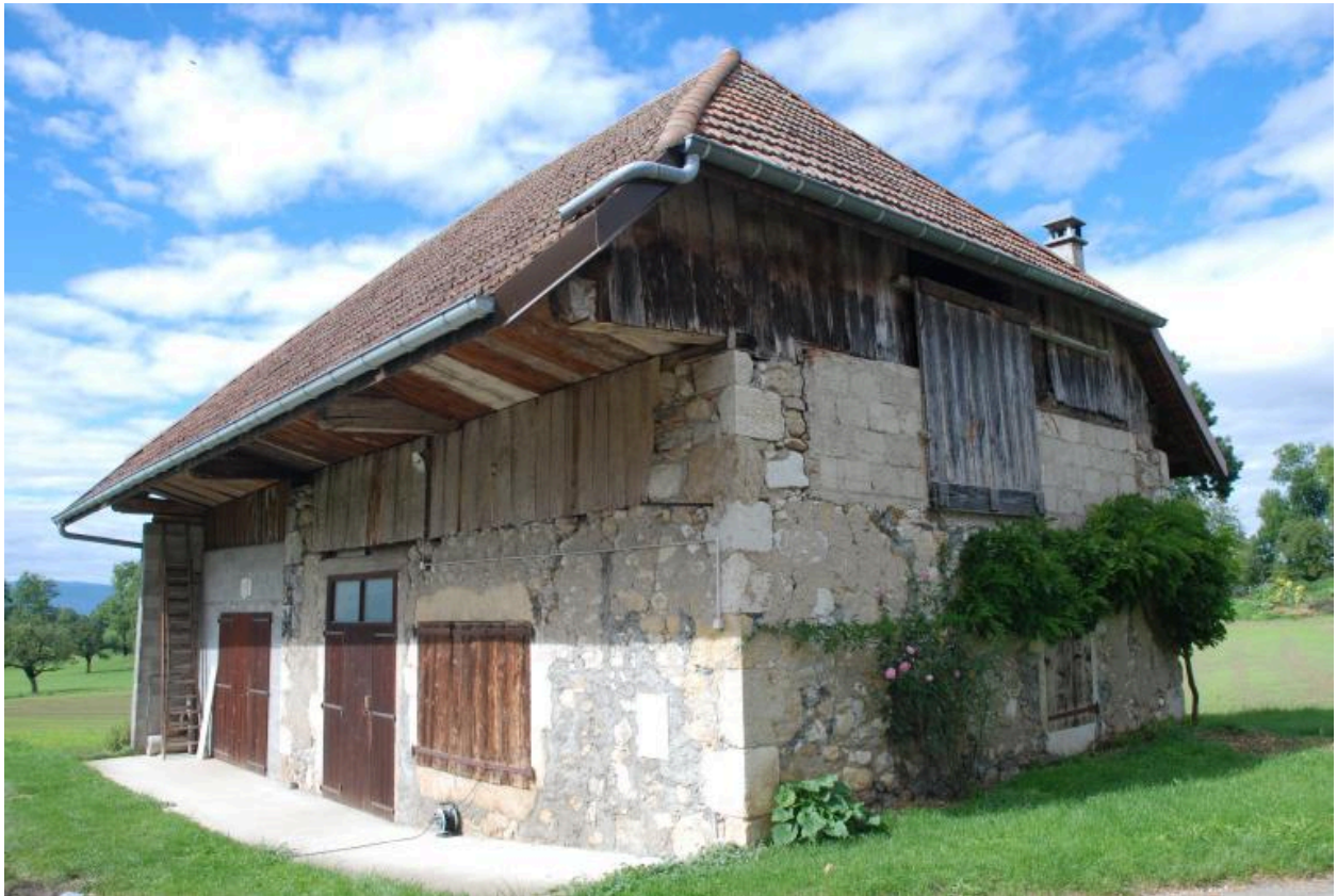
Vue d'ensemble de trois-quarts avant droit de la forge et hangar.
