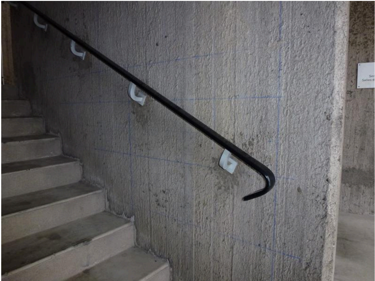
Intérieur de la tour d'escalier (avec les traits de maçon bleus sur le mur-noyau). (Photo chercheure.)
