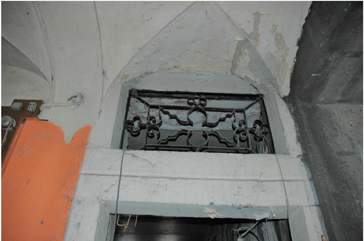
Vue intérieure du 1er étage : porte du palier de l'escalier avec imposte en fer forgé.
