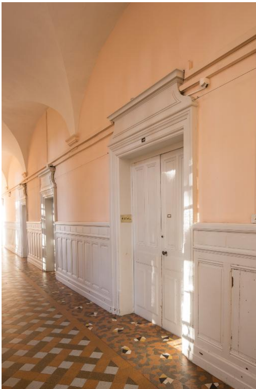
Bâtiment G. Galerie du rez-de-chaussée. Entrée des bureaux de l'intendance
