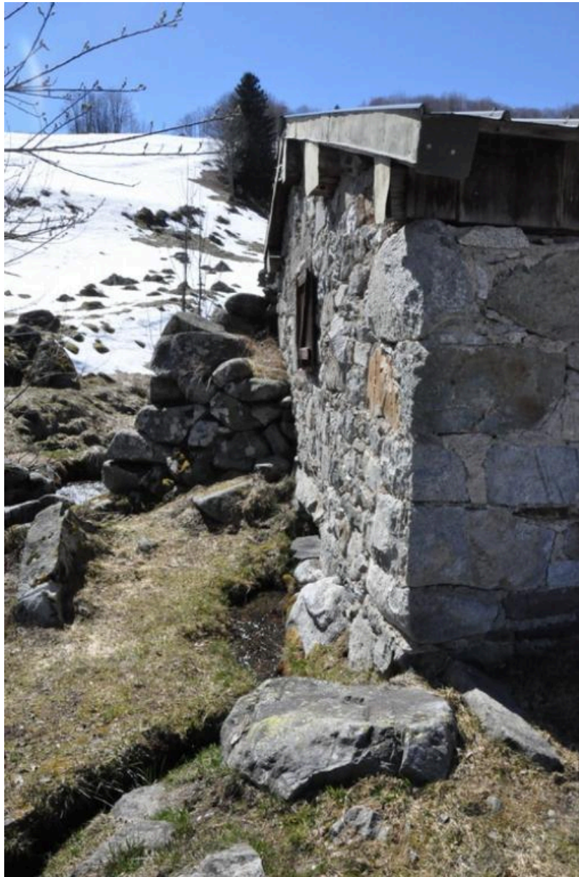
Pignon sud-est du bâtiment avec le canal de fuite.
