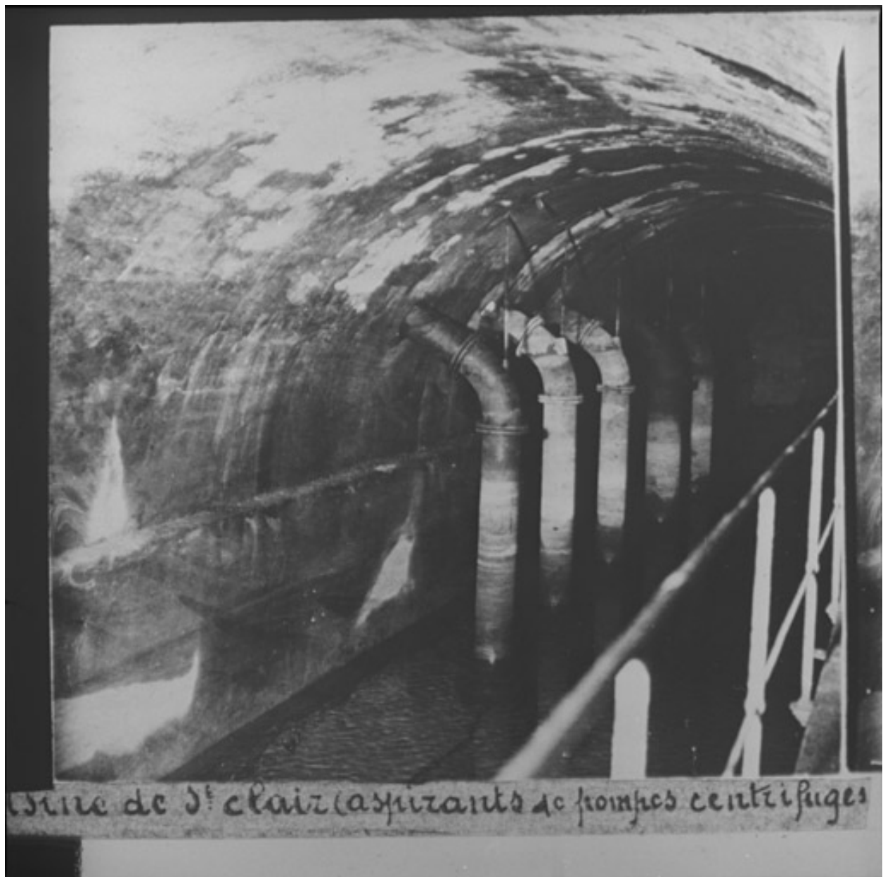
Usine de St-Clair aspirants des pompes centrifuges (Cie Générale des eaux)
