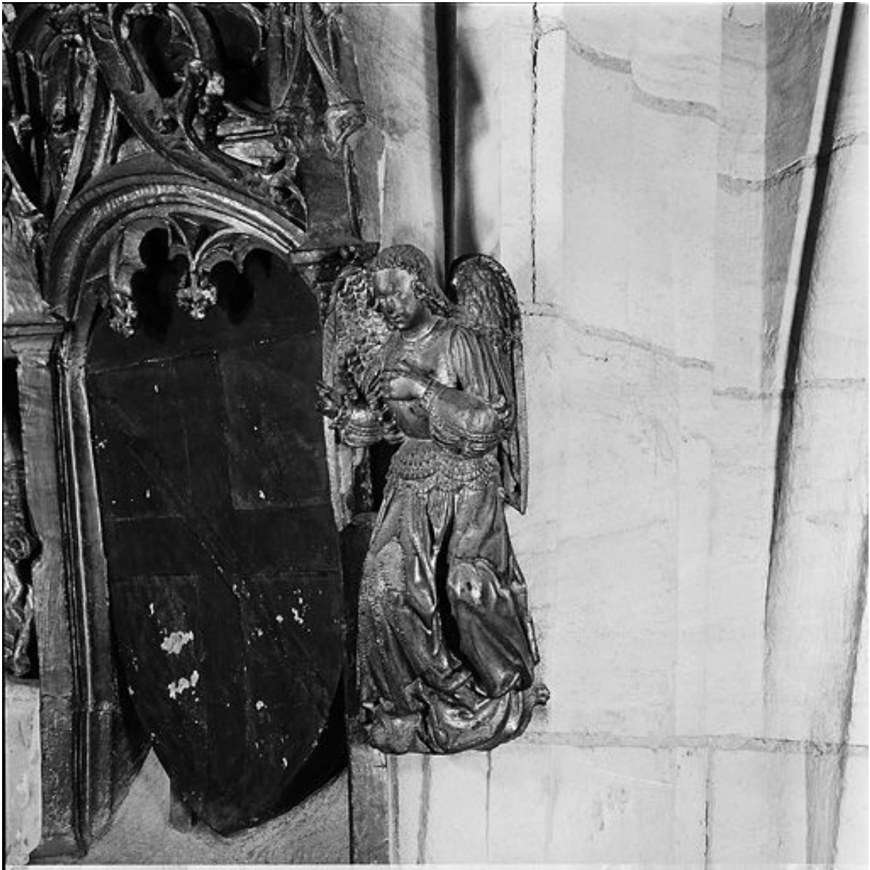
5e pilier sud de la nef en cours de restauration en 1977, armoiries à la naissance de la voûte du vaisseau central, détail
