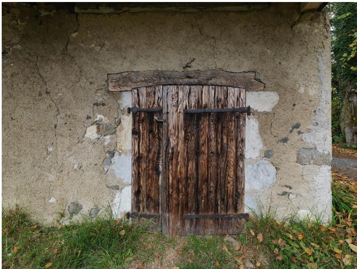
Détail de la porte de l'étable.
