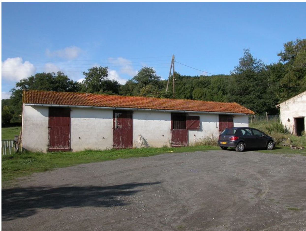
Vue des écuries.
