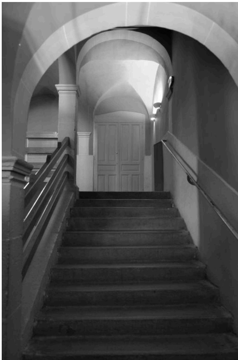
Escalier principal : 3e volée
