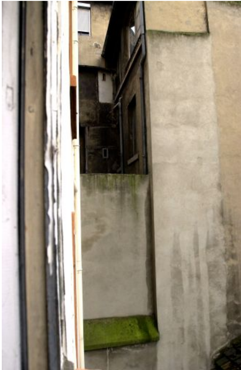
Vue du corps de bâtiment sur cour depuis le 9 quai Perrache
