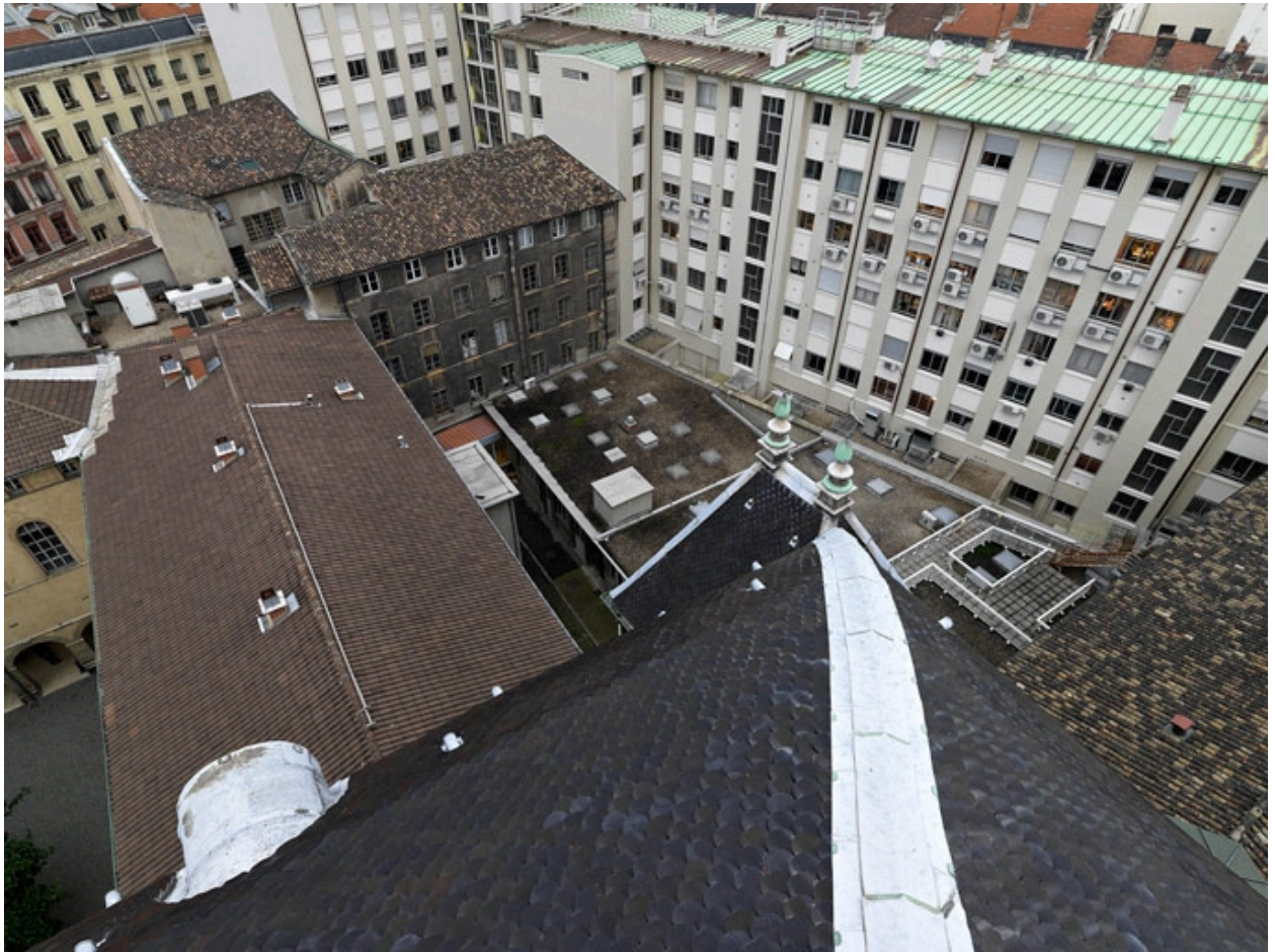
Bâtiment S. Corps de bâtiment nord donnant sur la cour du Magasin
