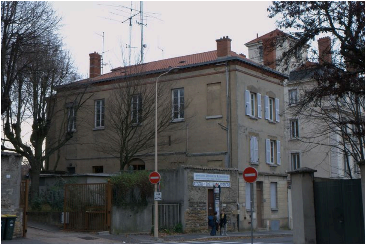
Bâtiment de la galerie, vue depuis le nord-est
