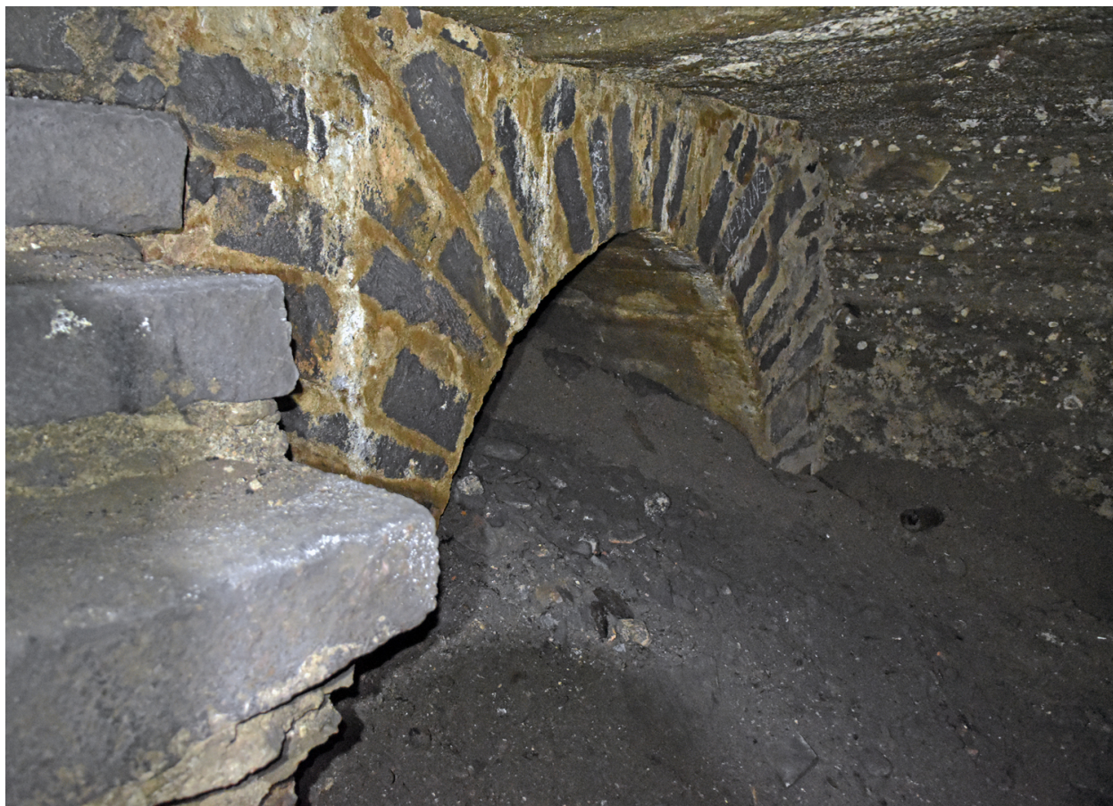
Caves nord : cave non relevée située au niveau -2, vue d'une arcade jouxtant la base de l'escalier
