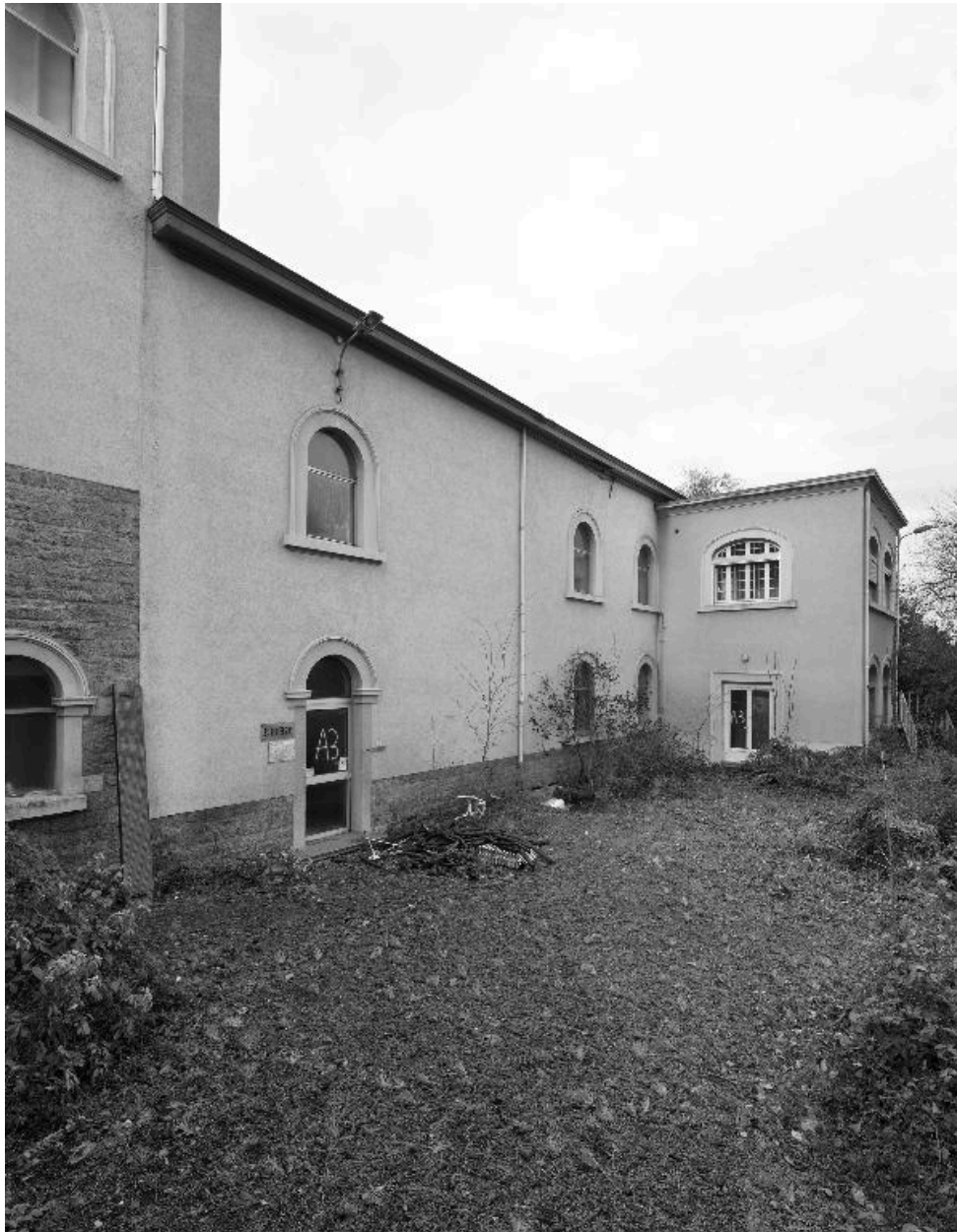
Bâtiment nord, élévation est (vue du sud)
