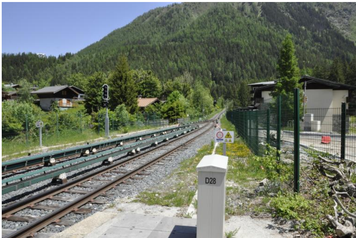
Détail des voies ferroviaires empruntant le pont
