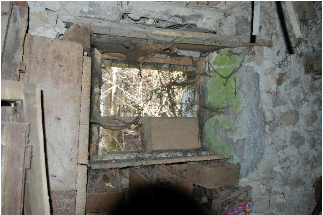
Second étage de soubassement de la partie moulin, baie daté 1875 dans le mur pignon ouest
