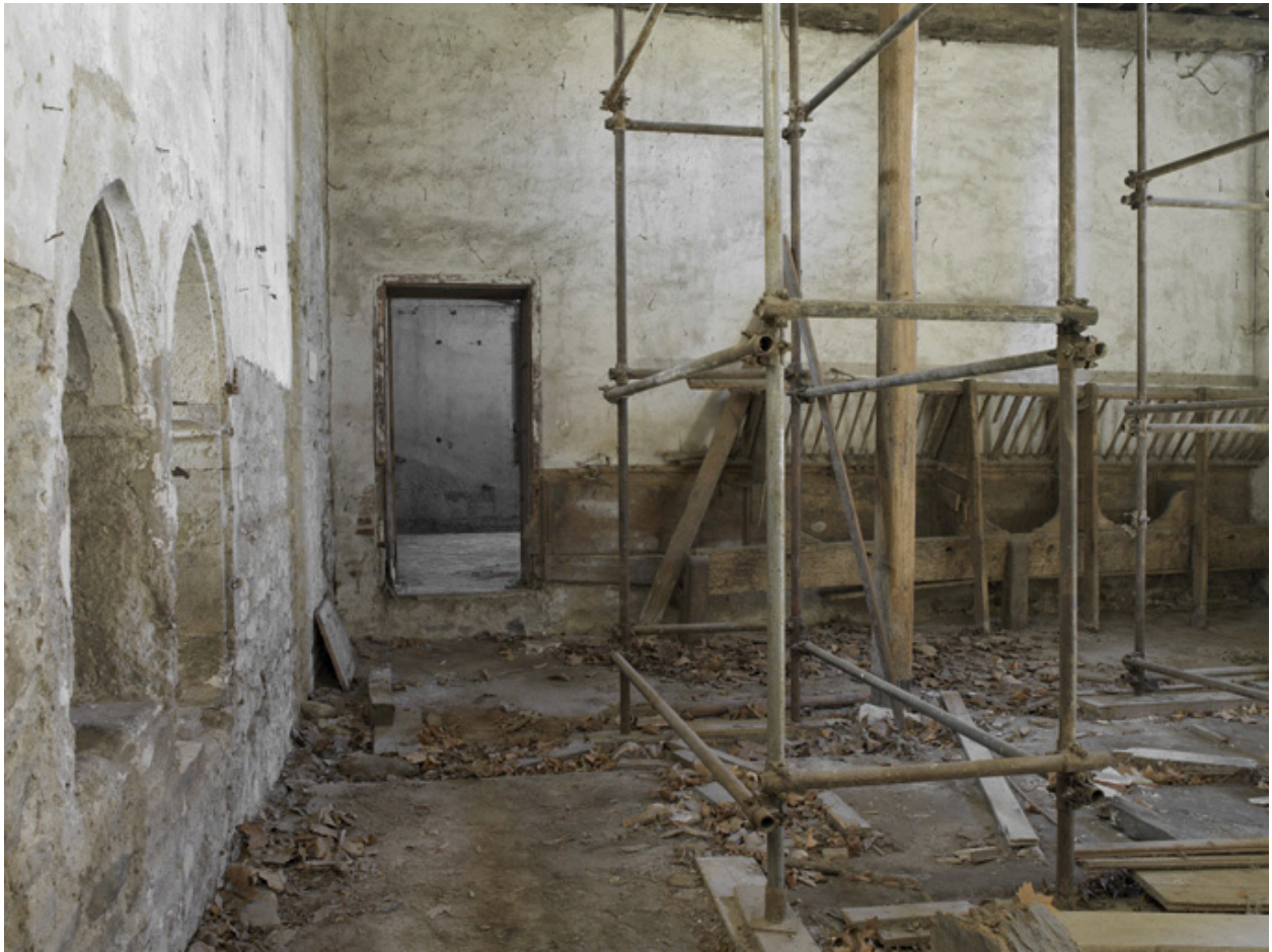
Vue d'ensemble du mur de refend central de la chapelle, depuis le chœur.
