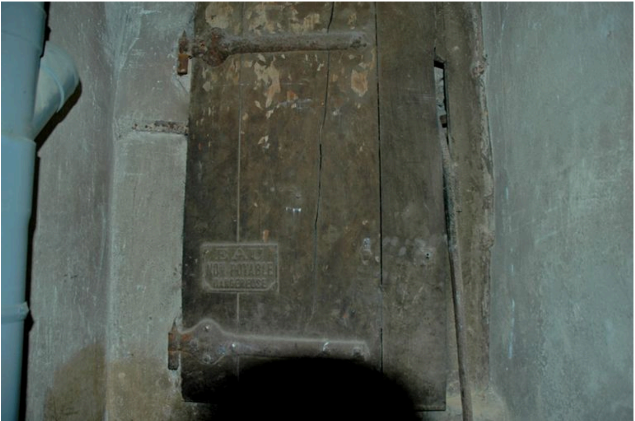
Porte du puits sous l'escalier
