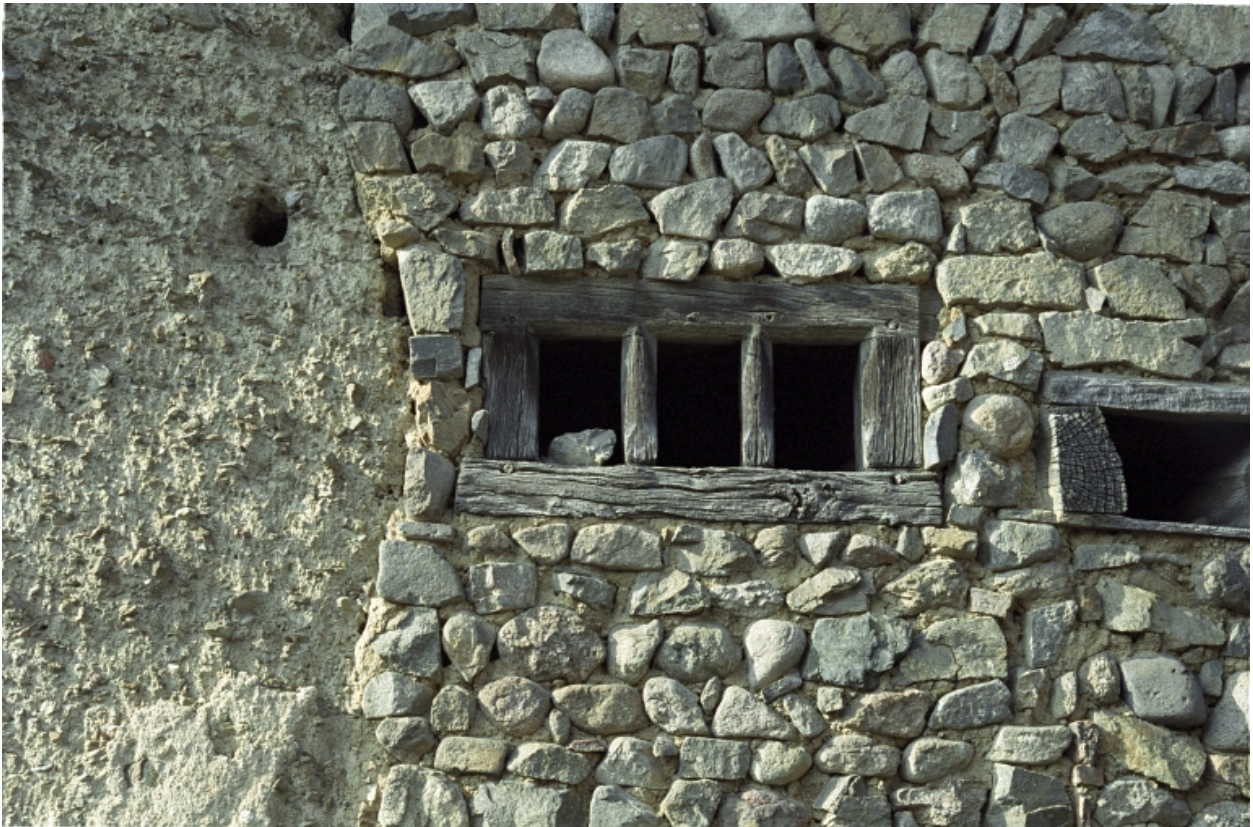
L'Hôpital-sous-Rochefort, le bourg, ferme (1982 AU 760). Détail d'un jour à barreaux de bois.
