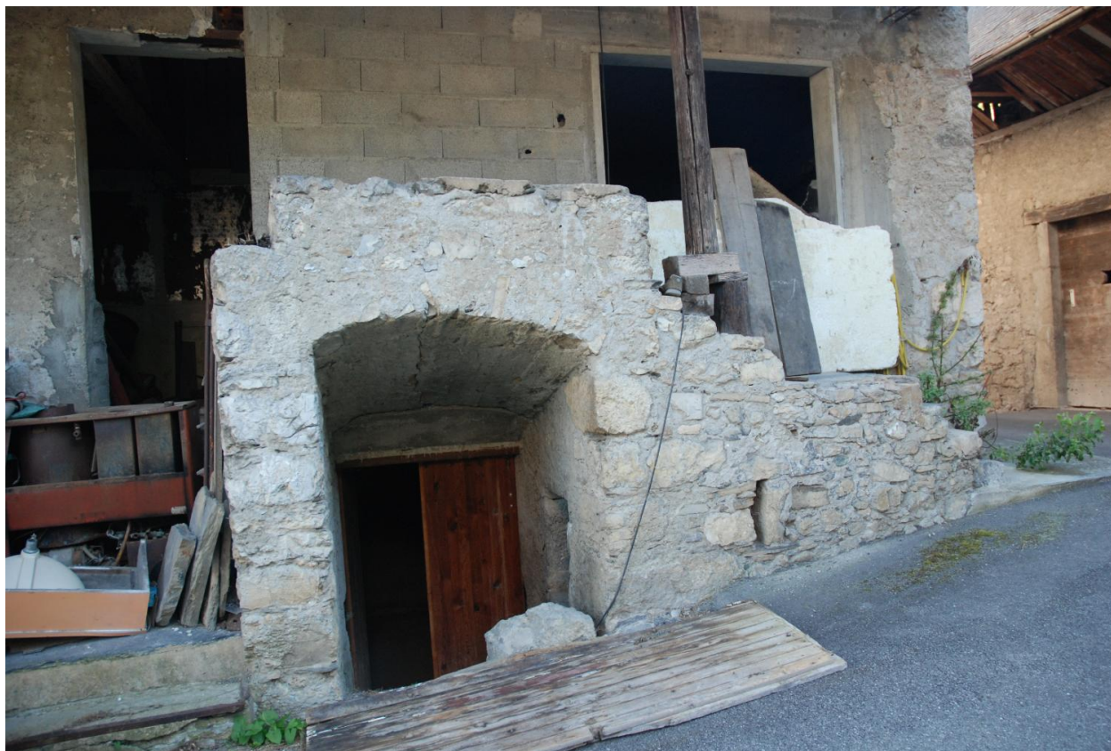
Maison de vigneron (2018 I1 136), détail de la descente de cave.
